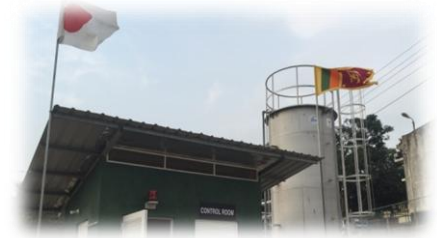
乳製品加工場排水処理施設 (平成28年10月納入・スリランカ)
